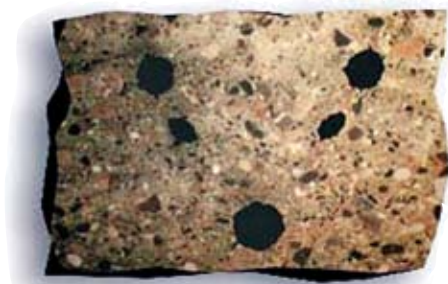
Schnitt durch einen unter Baustellenbedingungen eingespritzten Pantex Gitterträger
