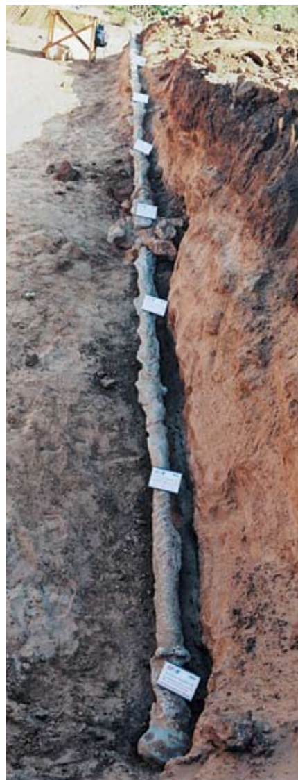
Exemple d'enrobage de coulis obtenu en utilisant l'Adaptateur Rotatif d'Injection AT - RIA
